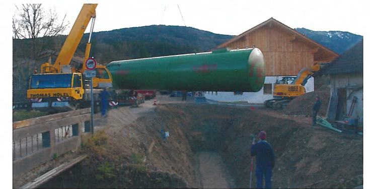
Andreas Sindlhauser, Hubert Mayr und Toni Streidl beim Einheben des 100.000 Liter Löschwassertanks
