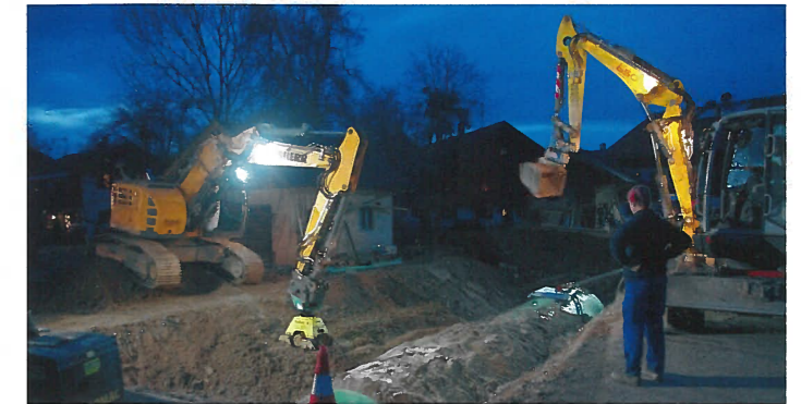
Verfüllung der Baugrube bis in die späten Abendstunden
